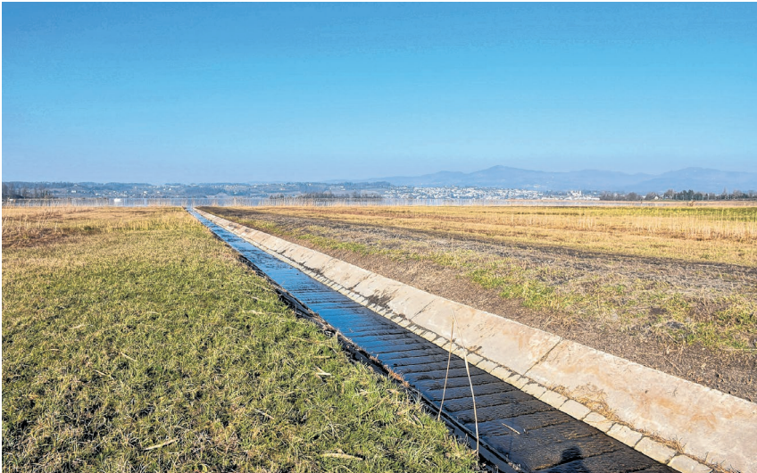
Der Hüöblibach im Inner Sack fliesst in einer Betonverschalung in den Zürichsee, sodass kein Wasser im Ried zurückgehalten wird.
