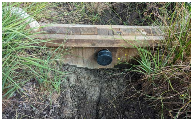
Bei längerer Trockenheit können die Entwässerungsgräben im Inner Sack trotz rückstauerender Spundwände trockenfallen.
