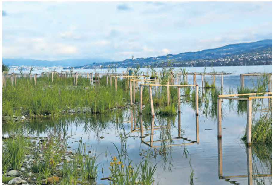
Die neu gesetzten Schilfkästen tragen dazu bei, das Ufer im Pfäffiker Ried wieder in einen natürlichen Zustand zu versetzen.
