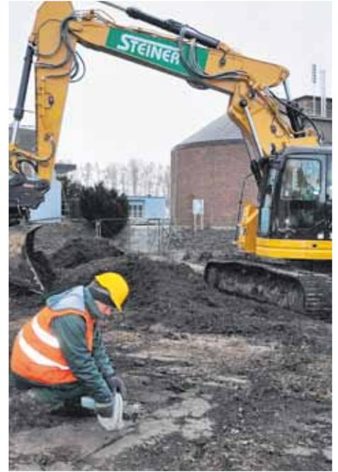
Als erstes wurde eine neue Baustellenerschliessung über den Sarenbach gebaut und anschliessend wurde in der Materialdeponie aus den 80er-Jahren Schaufel für Schaufel sorgfältig gemessen, triagiert und umweltgerecht entsorgt.
