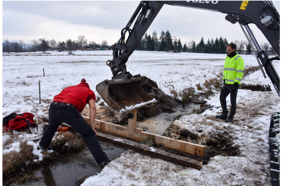
Philippe Keiser von der Stiftung «Frauenwinkel» und Urs Arnold von der Genossame Dorf-Binzen beim Einbau eines Spundbrettes mit dem bereits angebrachten Ablass. Zur besseren Bewirtschaftung der Riedflächen kann das Wasser vorher abgelassen werden.
