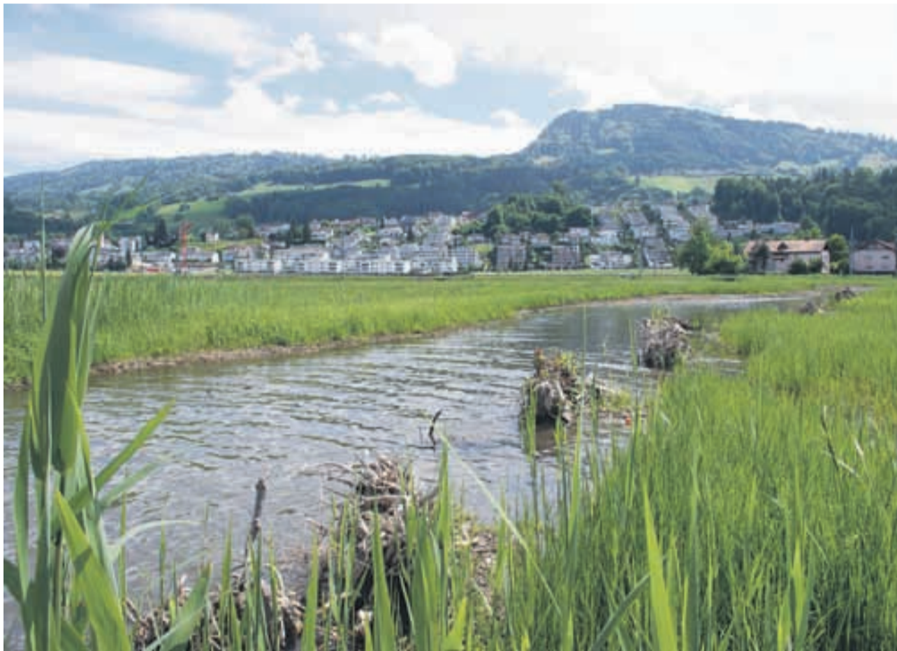
Der aufgewertete Jakoblibach bietet infolge grösserer Abflusskapazität auch verbesserten Hochwasserschutz.
