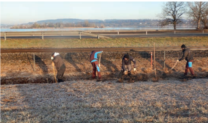
Links: Grabenarbeiten auf dem Gemeindegebiet von Freienbach in Hurden durch Zivildienstleistenden.
