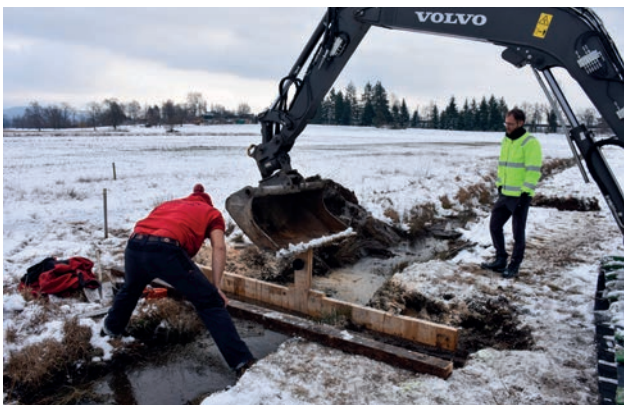
Der Einbau der Spundwände zur Einstauung der Entwässerungsgräben im Üsser Sack erfolgte durch die Genossame Dorf-Binzen, welche bereits im Hochmoor Schwantenua solche Spundwände einbaute.
