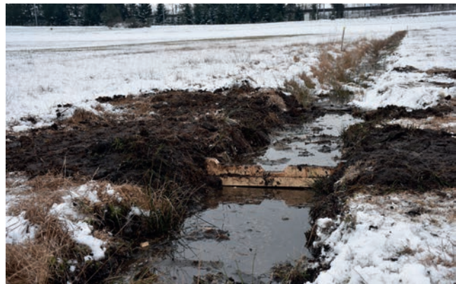
Der Einbau der Spundwände zur Einstauung der Entwässerungsgräben im Üsser Sack erfolgte durch die Genossame Dorf-Binzen, welche bereits im Hochmoor Schwantenua solche Spundwände einbaute.
