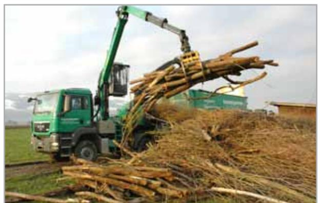
Das aus dem Schilfgürtel geborgene Schwemmgut und der Holzschnitt wurde vor Ort gehäckselt und abgeführt. Der Bagger bewegte sich ausschliesslich auf Baggermatratzen und schonte damit den Riedboden.
