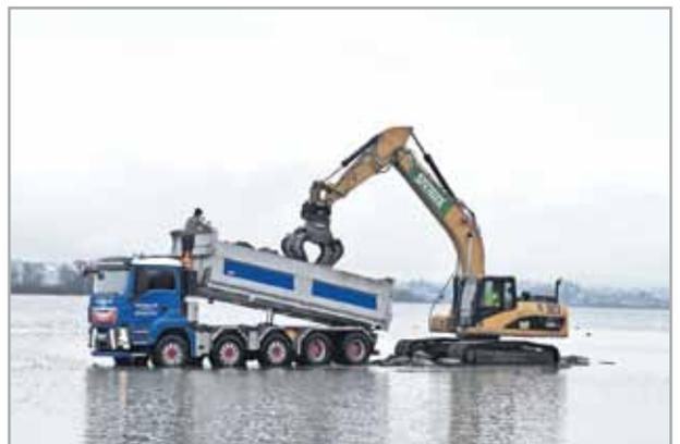
Tausende Tonnen von Schroppen bilden ein Riff und schützen das neue Flachufer (oben) vor Erosion.
