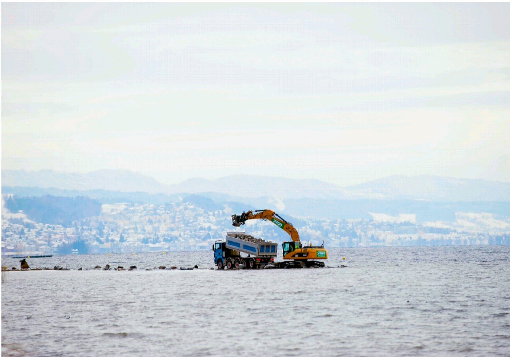
Als ob der Bagger schwimmen könnte: Damm als Wellenbrecher vor dem Naturschutzgebiet Frauenwinkel im schwyzerischen Pfäffikon. Foto: Reto Oeschger
