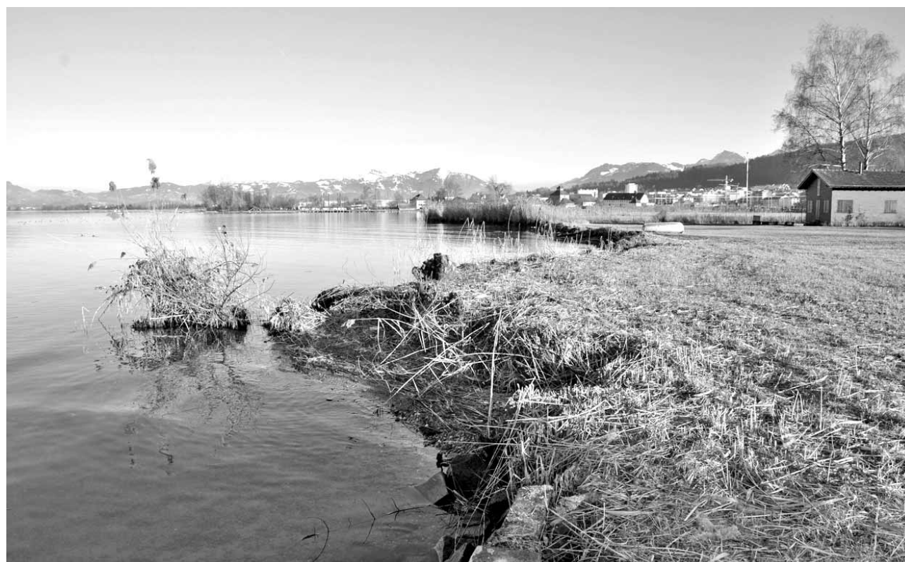
Das Gebüsch im See zeigt, wo noch vor wenigen Jahren die Uferlinie verlief. Unterdessen hat der Wellenschlag das Land abgetragen und in den See gespült. Eine Flachwasserzone mit Schilfgürtel soll Lebensraum zurückbringen.
