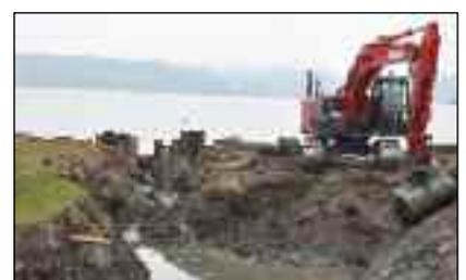
er in einem breiteren, naturnahen Bachbett in Richtung See. Vor der Baustelle wurde der Bach gestaut und umgeleitet, damit im Trockenem gearbeitet werden konnte. Eine Niederwasserrinne garantiert den Fischeaufstieg und der Weidenlebensverbau ist gleichzeitig Versteck, Schattenspender und Erosionsschutz. Im Seeuferbereich musste der See mit Larsen am Hineinfließen gehindert werden. Auch beim Sarenbach konnte der Hochwasserschutz massiv verbessert werden.
