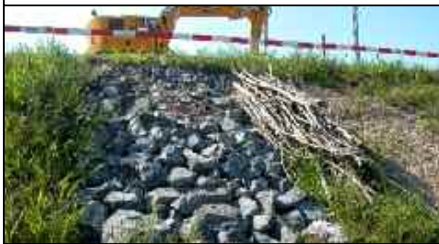
Lebensräume für Eidechsen am neuen SOB-Damm
